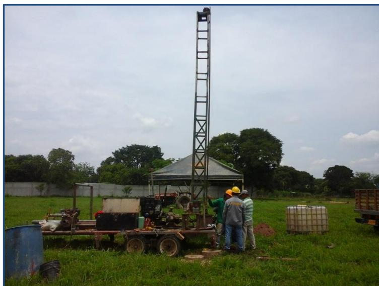
Figura 26. Exploración del terreno, perforaciones mecánicas.
