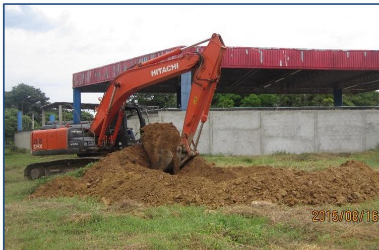
*Figura 25. Exploración del terreno, apertura de trincheras.*
